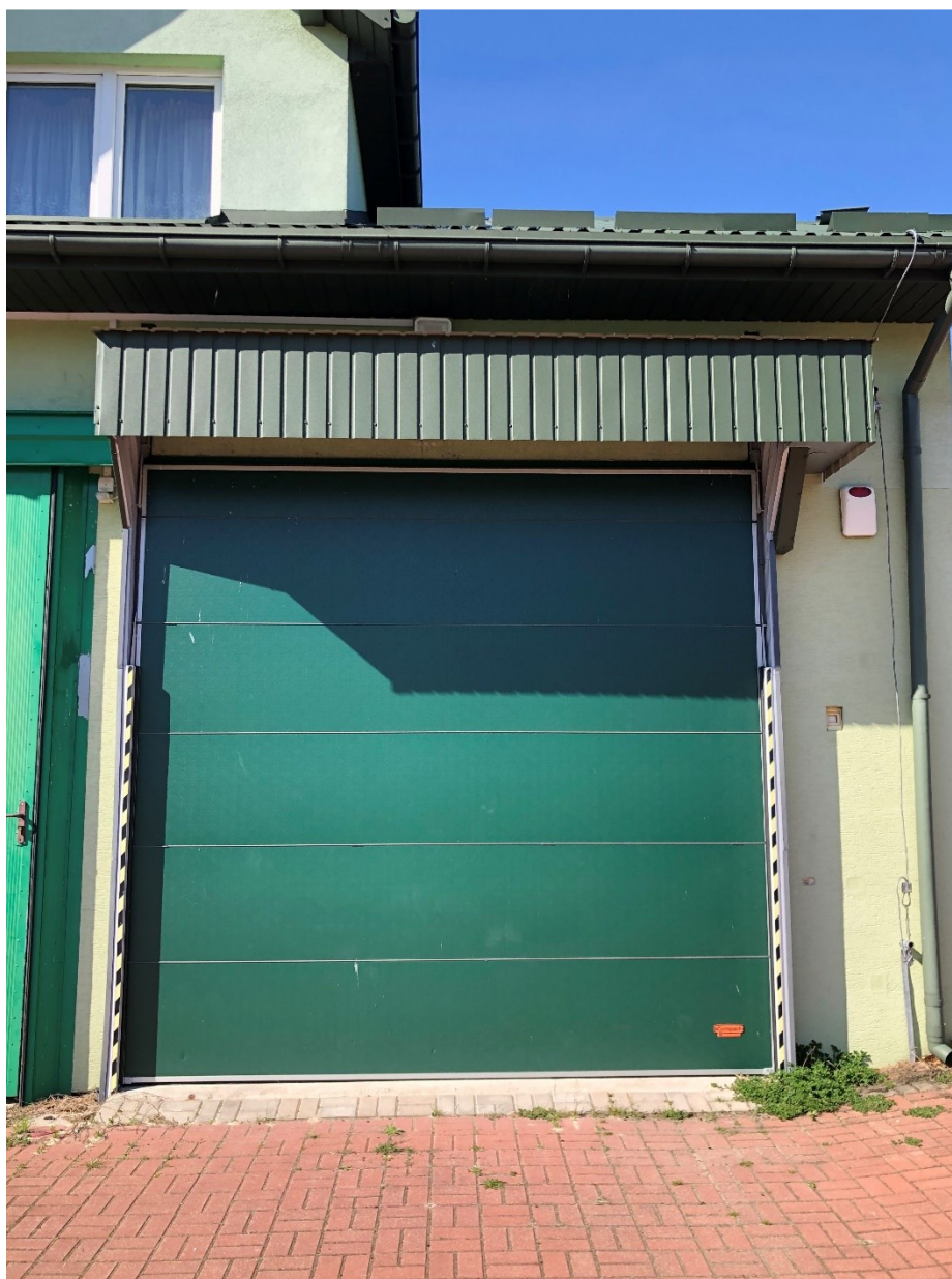
Zdjęcie nowych drzwi
