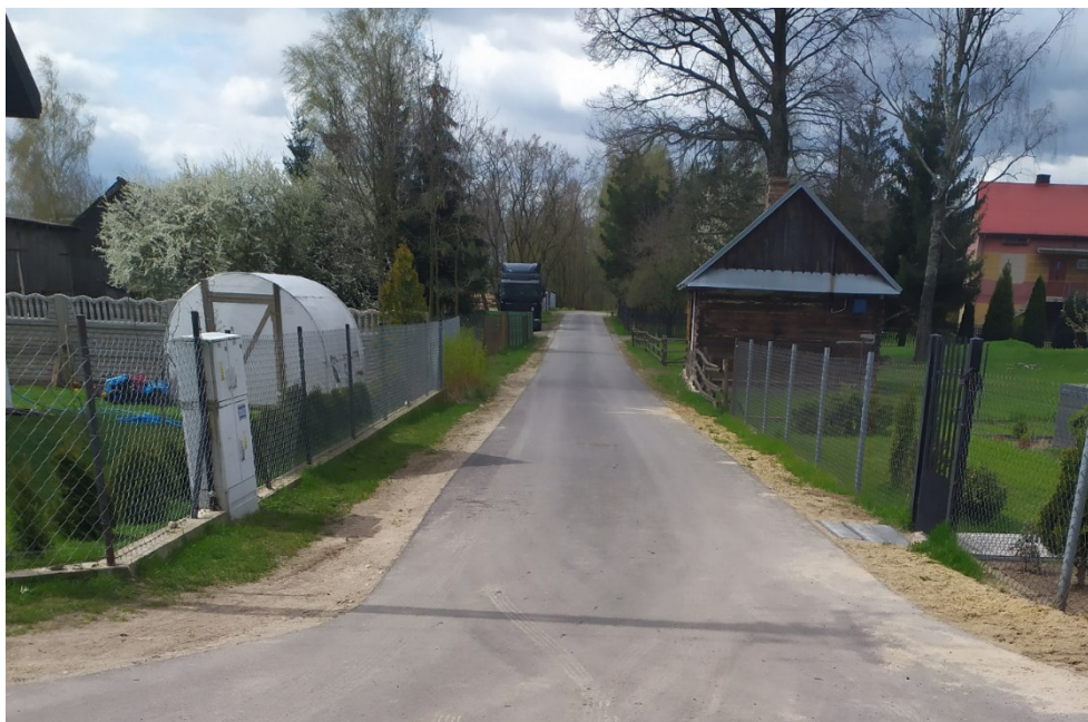
Widok nowego odcinka drogi
