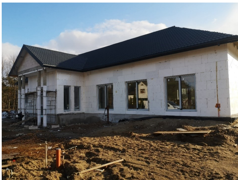
Widok dobudowanej części od ulicy, wymienionych okien oraz ocieplenia budynku
