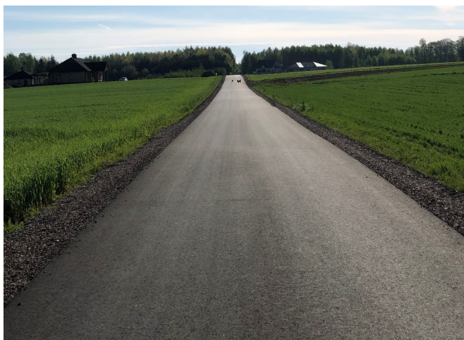
Widok nowego odcinka drogi od strony miejscowości Podzdrój
