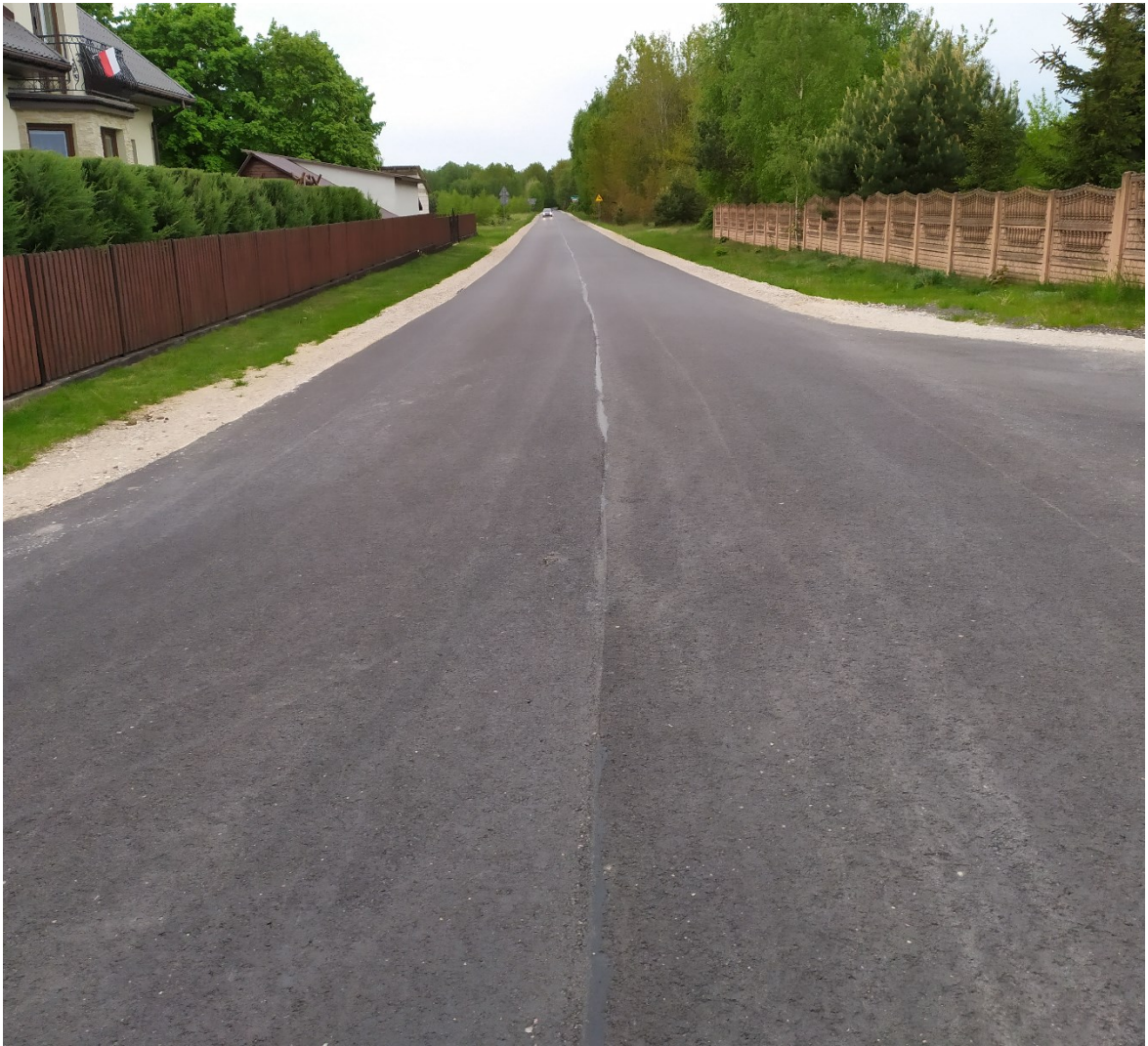
Widok drogi po przebudowie ze skrzyżowania w kierunku Gminy Stoczek Łukowski
