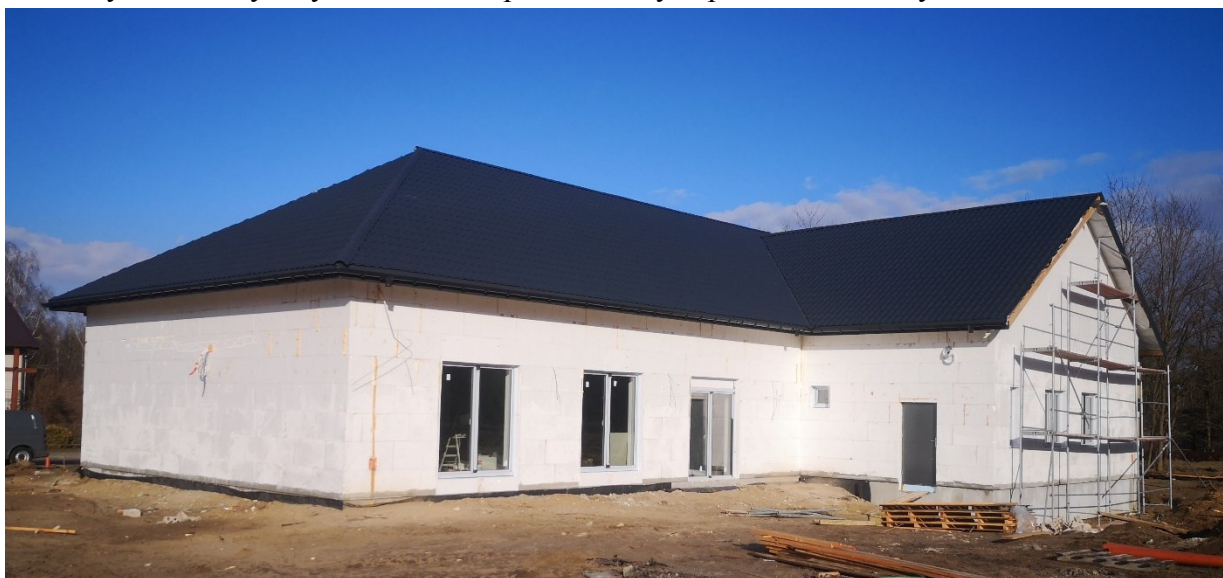
Widok nowego dachu oraz dobudowanej części z tyłu budynku
