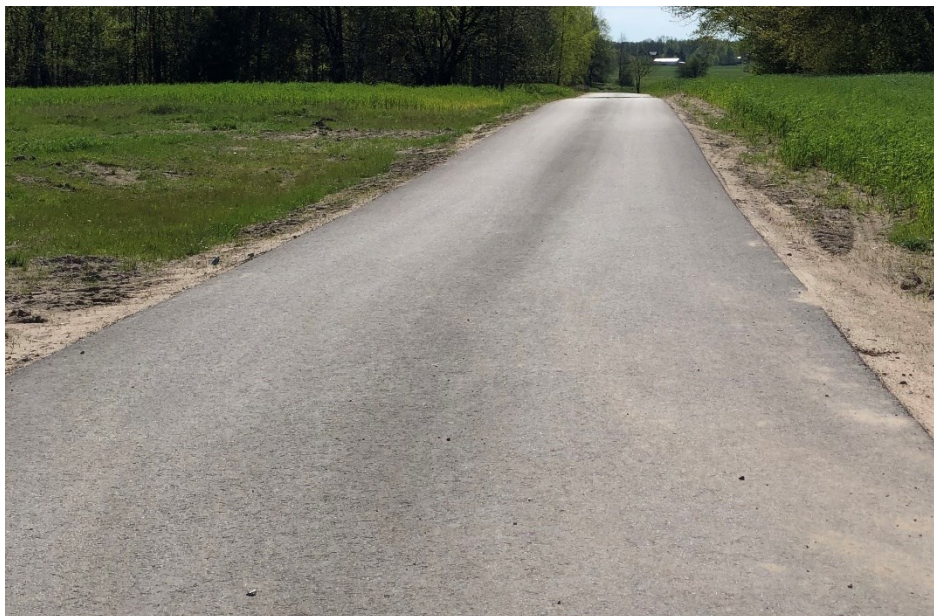
Widok nowego odcinka drogi
