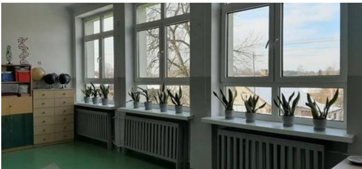
Sala po remoncie
