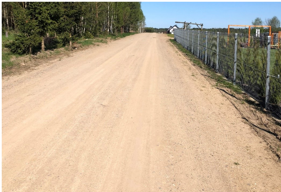
Widok nowej nawierzchni drogi
