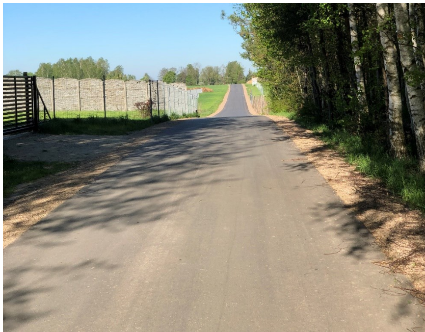
Widok nowego odcinka drogi od strony Domanic-Kolonii
